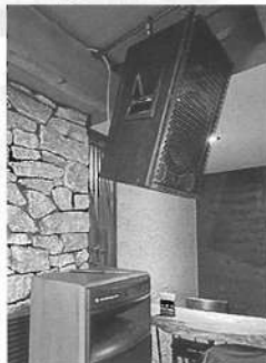
ピアノはSM57×2、Roland M-200i Live Mixing Consoleに、メインはMeyer sound UPA-1B、転がしはElectro-Voice。ほとんど生音でもっともシンプルなセッティング
